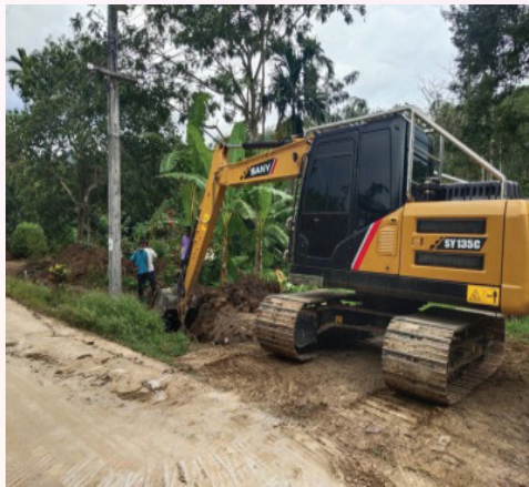
ภาพระหว่างการดำเนินการและดำเนินการแล้วเสร็จ
