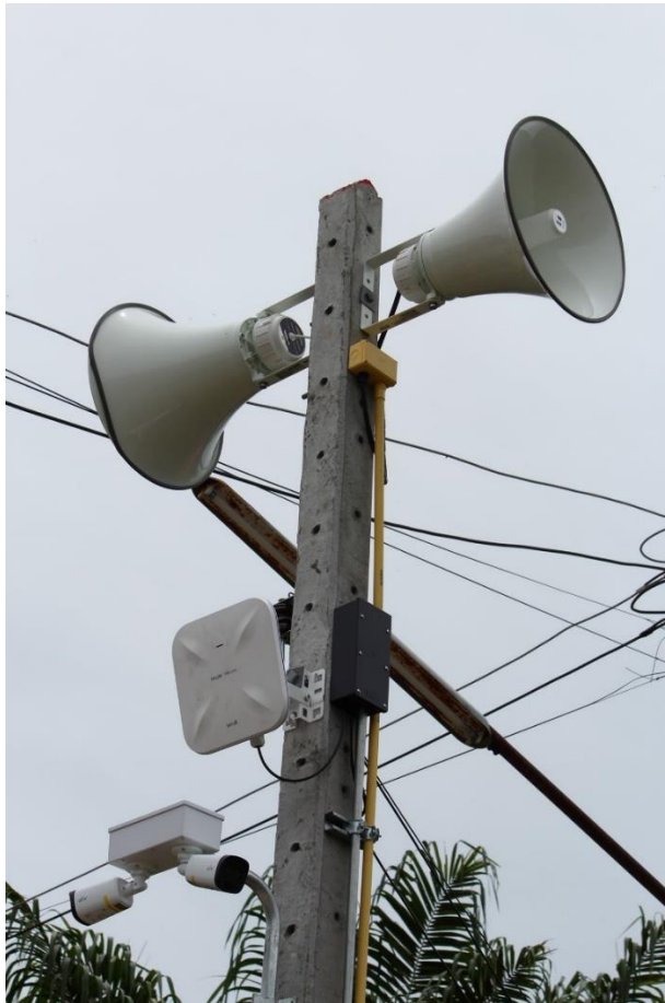
ภาพที่ 2.18 ตัวอย่างเสาอัจฉริยะ ประกอบด้วย กล้อง CCTV, Wi-Fi, PA
