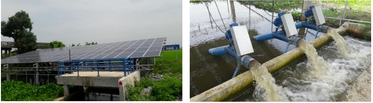
ภาพที่ 3.35 ระบบบริหารจัดการน้ำด้วยโซลาร์เซลล์ ที่มา : https://ppp.energy.go.th กระทรวงพลังงาน
